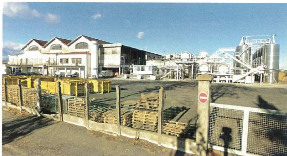
Photo de la cave coopérative à l'état actuel
